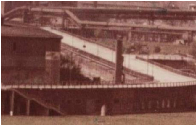
Blick auf die Hochstraße, 1950er Jahre
